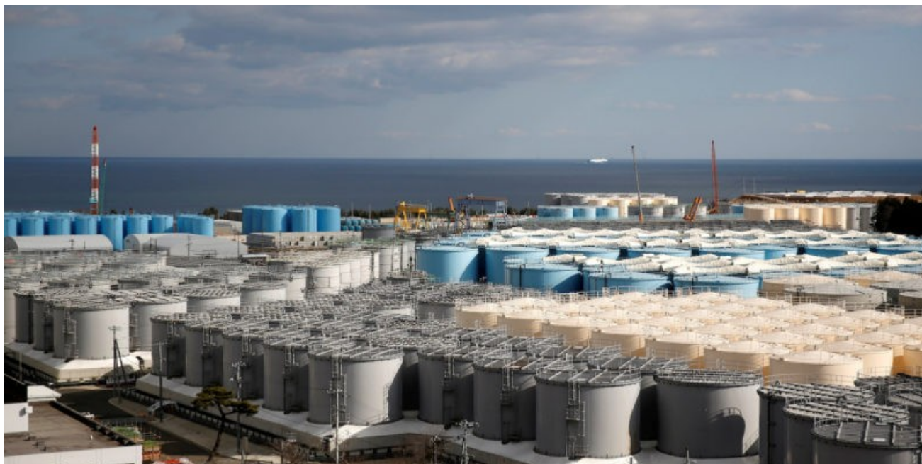
Stockage d'eau radioactive à Fukushima... avant déversement dans le Pacifique !
